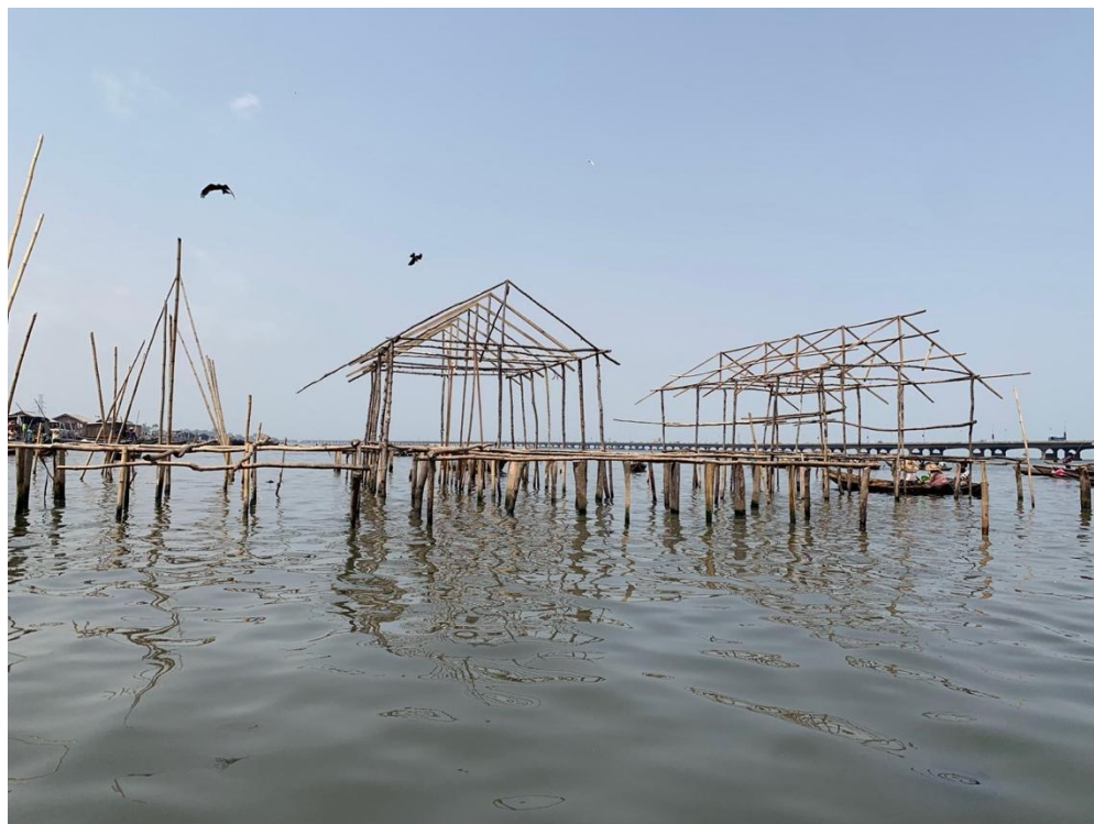
Ryc. 9 początek konstruowania nowej zabudowy na Lagunie Lagos, marzec 2024, opracowanie własne
